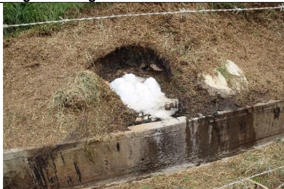
Fotografía 9. Pozo de inspección No. 2 con espumado y evidencia de rebose. Coordenadas: 4°31'19.93"N - 74° 7'41.47"W
