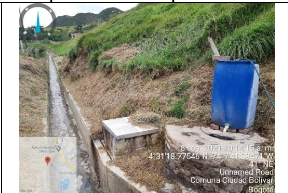
Fotografía 10. Pozo de inspección No. 3 con sistema de dosificación de antiespumante. Coordenadas: 4°31'18.77"N - 74° 7'41.39"W
