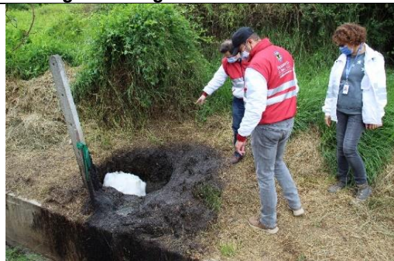
Fotografía 7. Pozo de inspección línea de descarga de lixiviados provenientes de la PTL con espumado. Coordenadas: 4°31'22.51"N - 74° 7'41.80"W
