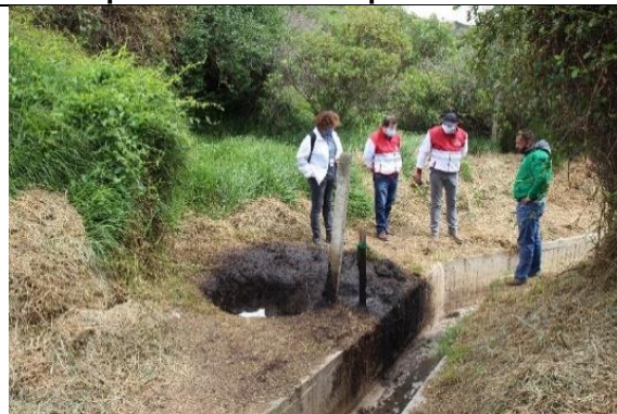
Fotografía 8. Pozo de inspección línea de descarga de lixiviados provenientes de la PTL con evidencias de rebose a canal paralelo. Coordenadas: 4°31'22.51"N - 74° 7'41.80"W
