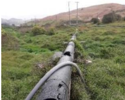
Fotografía 33. Cañuelas (tubos de conducción) abiertas sin ser atendidas por el consorcio CGR.
