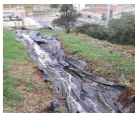
Fotografía 34. Líneas de conducción sin mantenimiento y con la geomembrana en mal estado.
